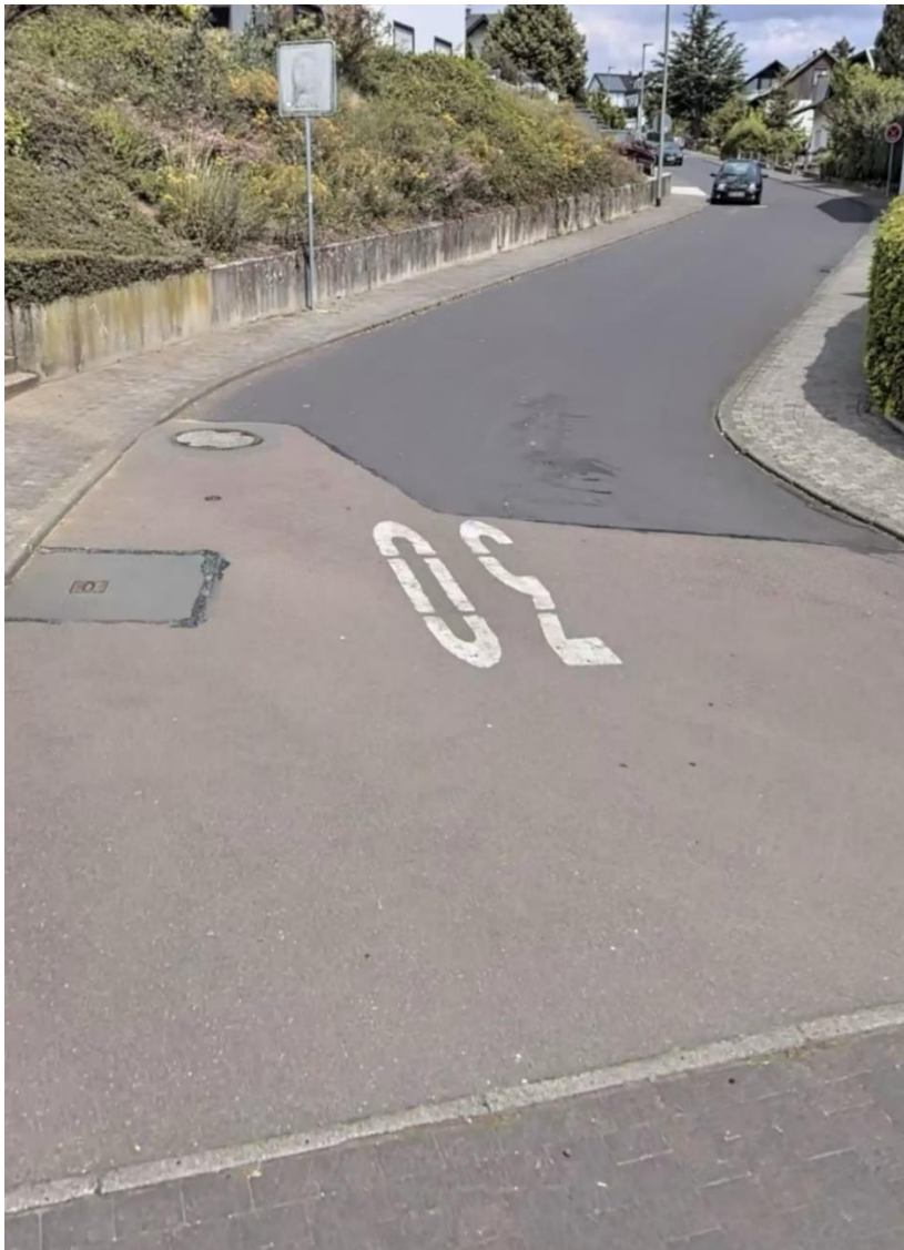
Abbildung 4.8: Straße zur Erlenwies, fehlende Regeneinläufe/Bergeinläufe (Maßnahme 9)
